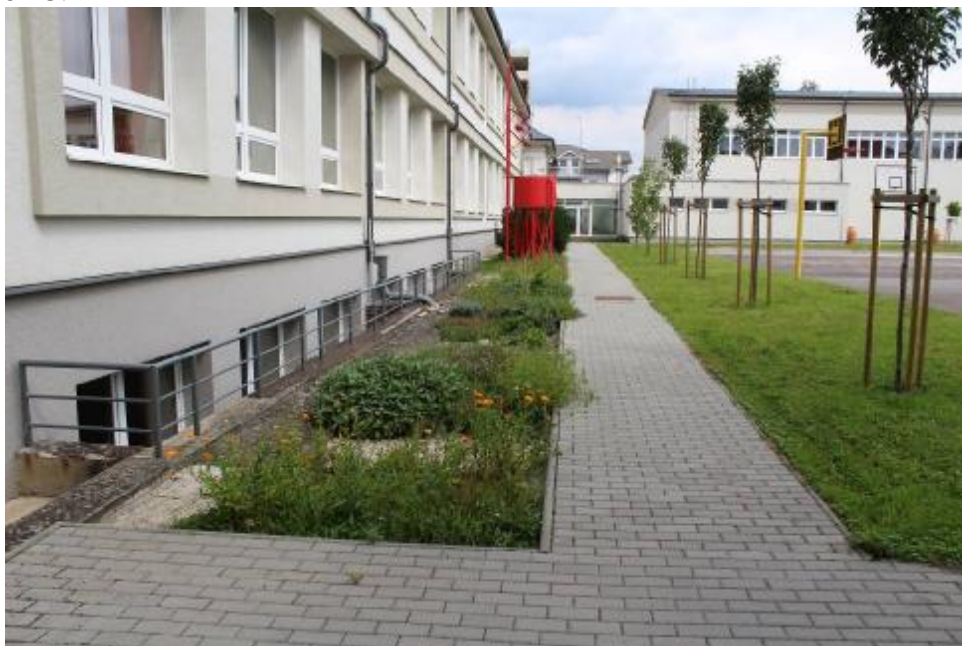
Obrázek 33: Teplota zeleně (Sp1) je 20.8 °C, povrchu chodníku (Sp2) 31.0 °C a zděné fasády (Sp3) 33.6 °C.
